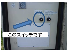
弁天グラウンド照明
